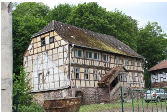
Im Rahmen des Aufbaus eines ambulanten Kurbetriebs wurde das verfallene Verwalterhaus in Neustadt/ Harz saniert. (Foto: RAG Südharz/2015)
