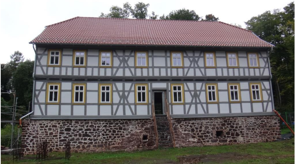
Im Rahmen des Aufbaus eines ambulanten Kurbetriebs wurde das vorher verfallene Verwalterhaus saniert und ab 2019 als Haus des Gastes genutzt. (Foto: RAG Südharz)
